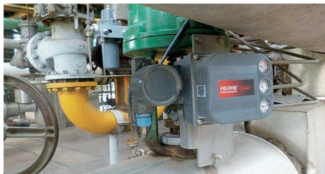
Na zadnej strane ventilu sa nachádza digitálny regulátor FIELDVUE DVC6200 s funkciou online monitorovania a možnosťou pokročilej diagnostiky.
