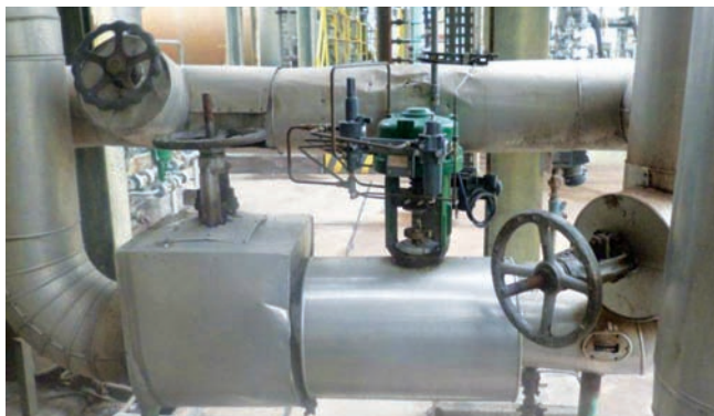
Pôvodné ventily nahradili spoľahlivé ventily Fisher vhodné do náročného prostredia reformingu.
